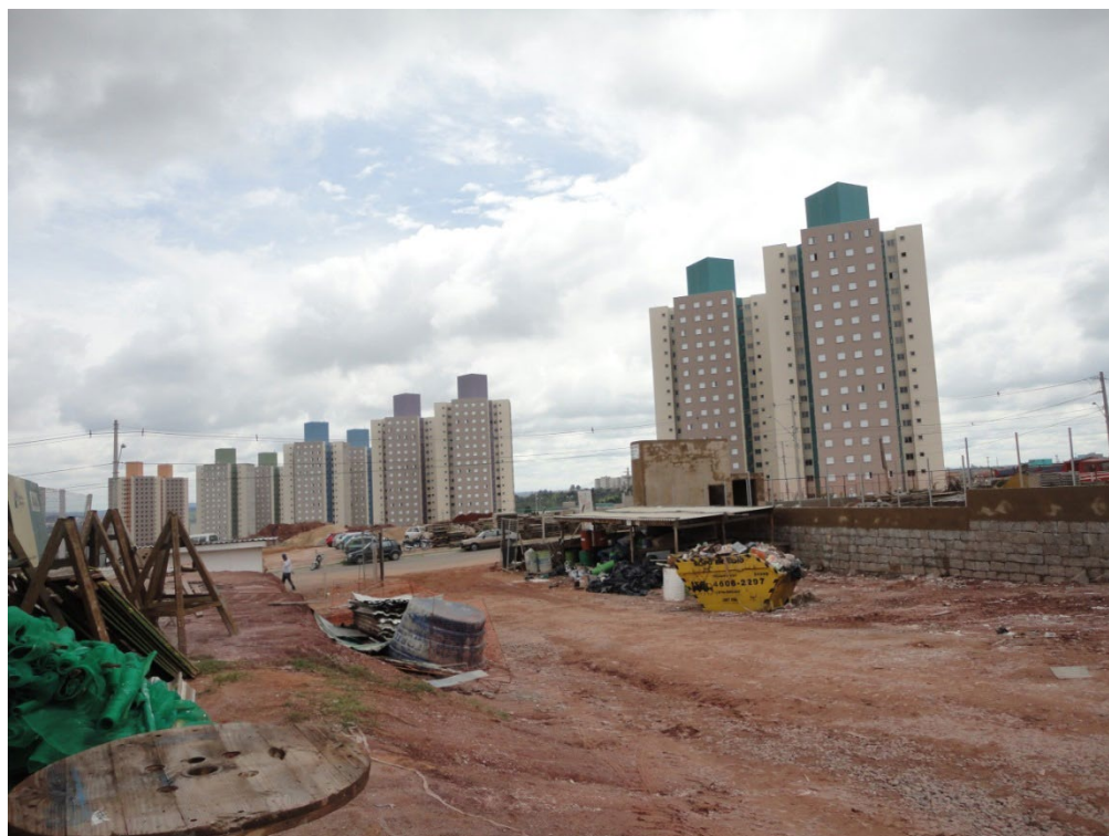
Construtora A - Empreendimento 2.
