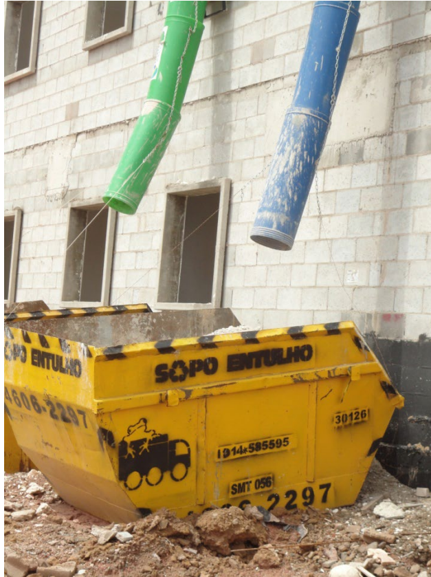
Construtora A - separação de entulho para descarte (1).
