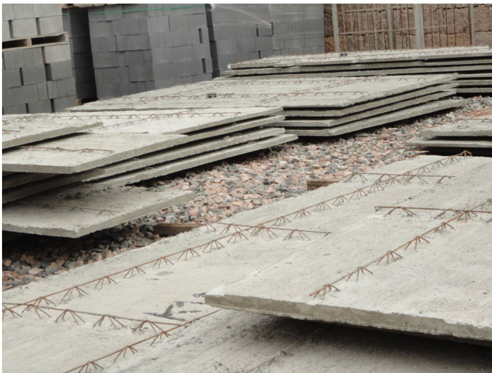
Construtora A - Lajes pré-moldadas Alvenaria estrutural.
