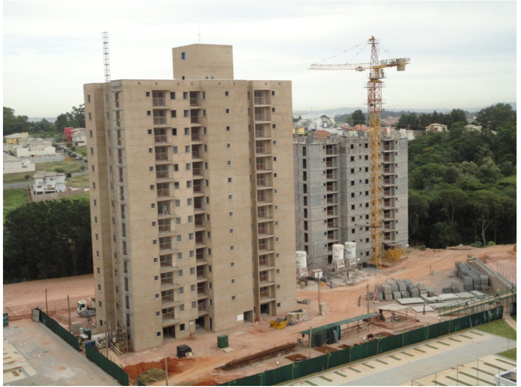
Construtora A - Empreendimento 1.
