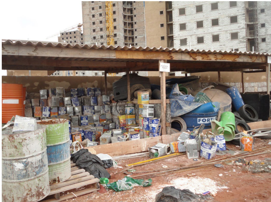
Construtora A - Separação de entulho para descarte_2.
